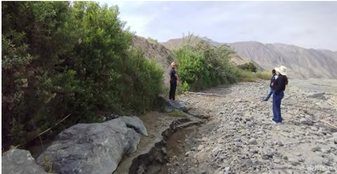
FIGURA N°02: TRAMO CRITICO 03, VISTA FINAL DE TRAMO 03 DE 30M SIN ROCA EN TALUD Y BASE DE TALUD DEBIDO A SOCAVACION,
