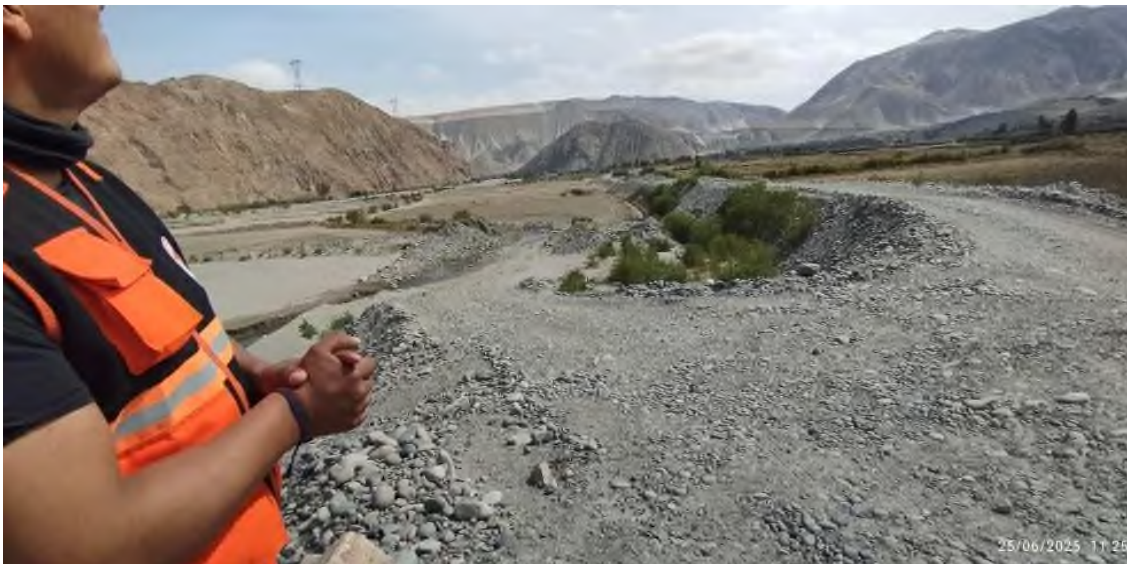
FIGURA N°03: TRAMO 04, VISTA DE INICIO DE TRAMO 04 CON ACTIVIDADES EN SECTOR EL TORO, TALUD DE DIQUE NO CUENTA CON PROTECCION, SE REQUIERE ENROCADO TEMPORAL
