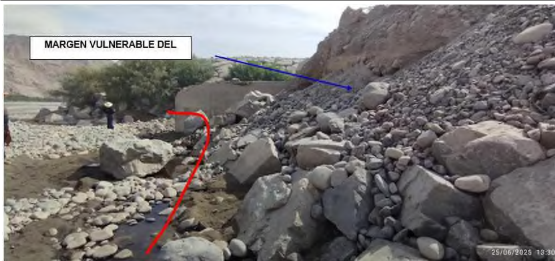
FIGURA N°01: TRAMO 01 INICIO DE PUNTOS CRITICOS EN SECTOR EL TORO, TRAMO AGUAS ARRIBA DE SALIDA DE QUEBRADA HUAYRONDO, TALUD SIN ENROCADO DE PROTECCION
